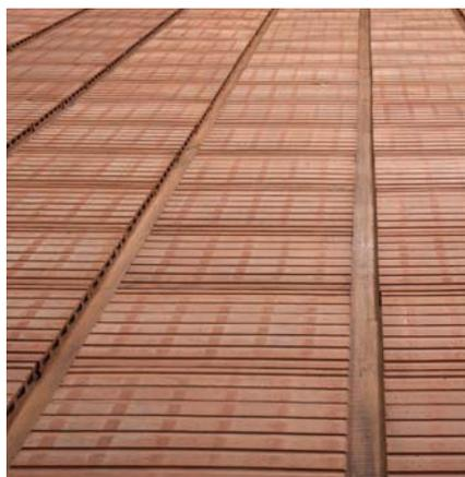
**2.** A questo punto si stende la membrana con relativo fissaggio dei connettori. – *At this point a membrane is laid and it is fastened by related connectors.*
