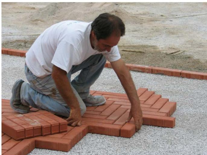
In alcune applicazioni pedonali, la sabbia può essere direttamente "spazzata" nelle fughe. Comunque, in tutte le applicazioni veicolari, la sabbia viene "spazzata" nelle fughe e i mattoni devono essere vibrati usando l'apposita attrezzatura vibrante-compattatrice.
