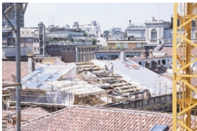
Vista dall'alto della ristrutturazione in fase di completamento.
