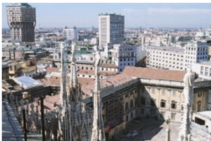
Ristrutturazione del Palazzo Reale e suo adattamento a Galleria d'arte contemporanea.
