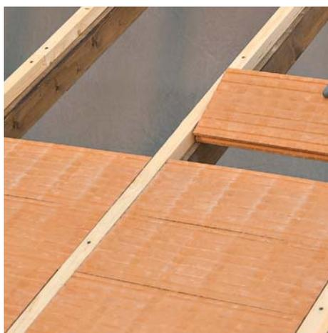
**2.** Dopo avere rasato le fughe, si disporrà lo strato isolante, base di partenza per gli strati successivi. – *After spreading the insulator over the tiles, we place the isolating layer, the base for all roofs.*
