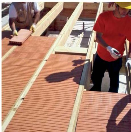
**2.** Si procede al fissaggio dell'OSB. – *Then we clench the OSB layer.*
