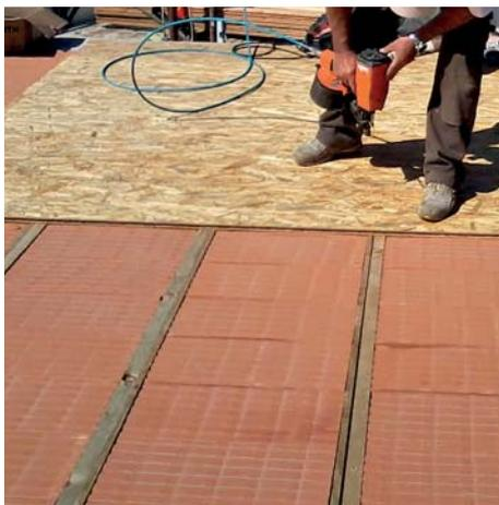
**3.** Quindi segue il montaggio di tavole dello spessore di progetto posizionate a 45 gradi rispetto alla parete. – *Then we lay down strips of wood with projected thickness and we place this layer posed at 45° toward the wall.*
