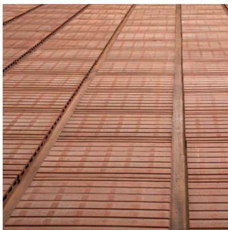
**2.** A questo punto si stende la membrana con relativo fissaggio dei connettori. – *At this point a membrane is laid and it is fastened by related connectors.*
