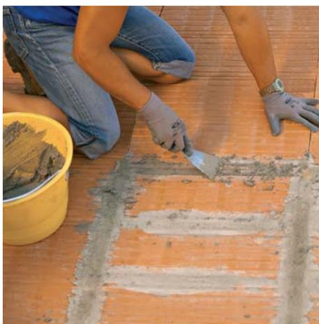
**3.** Si stende una membrana per evitare il contatto tra cemento e terracotta. Si procede realizzando la soletta con rete elettrosaldata – *A membrane is laid so that there is no contact between concrete and terracotta. Then the slab of concrete can be poured with an arc-welded mesh.*
